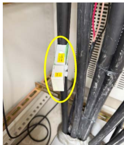
写真1 ジバでんきを設置した配線
