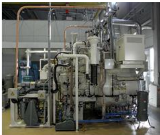
多目的真空熱処理炉
