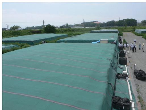
図 13 ガス透過性防水シートが適用された除染廃棄物仮置場
