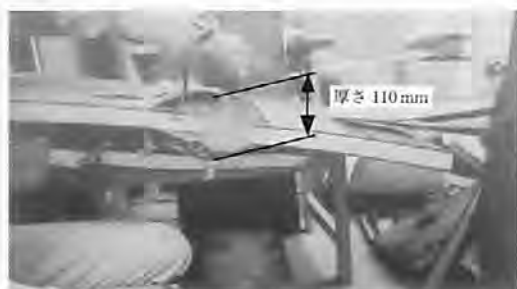
図11 ジョイント部厚さ測定
