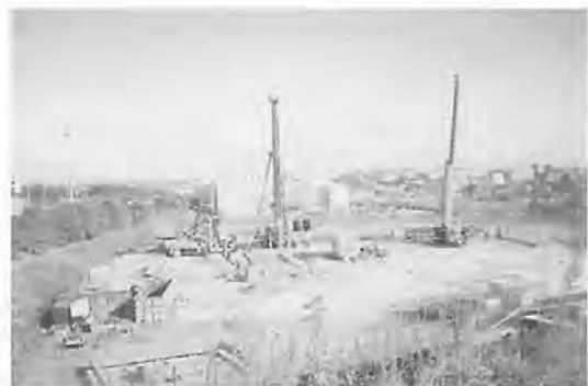
図7 複合シート建込み機械配置
