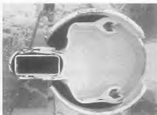
図5 ポリウレタン注入状況
