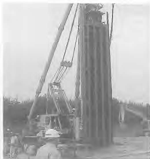
図8 複合シート建込み状況
