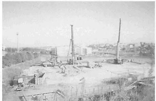
図7 複合シート建込み機械配置
